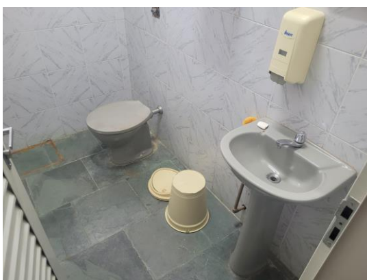
FOTO 05 – BANHEIRO A REFORMAR
