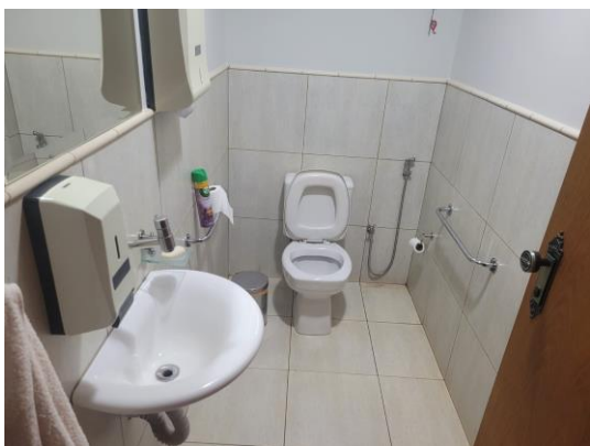
FOTO 03 - PORTA ACESSÍVEL A COLOCAR
