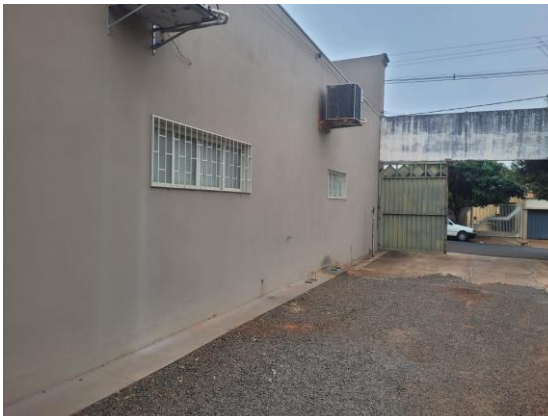
FOTO 17 – PORTA CORTA FOGO PARA INSTALAR
