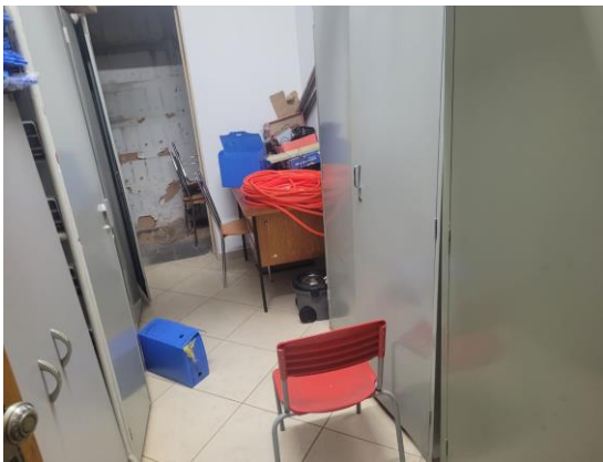
FOTO 09 – LOCAL DA LAVANDERIA A CONSTRUIR
