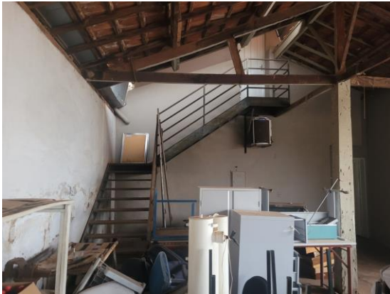
FOTO 15 – COZINHA PARA CONSTRUIR
