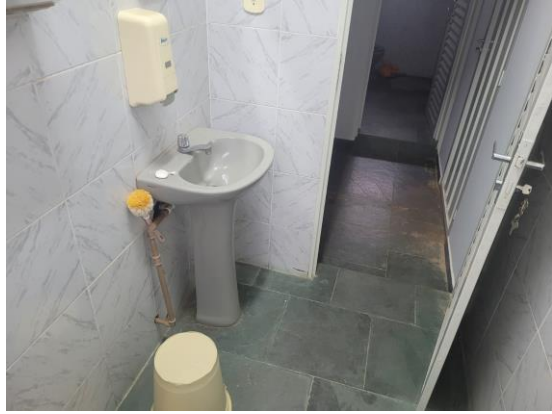
FOTO 08 – BANHEIRO A REFORMAR
