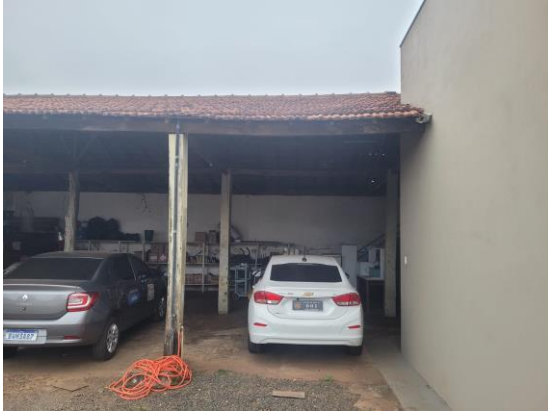
FOTO 13 – GARAGEM PARA CONSTRUIR
