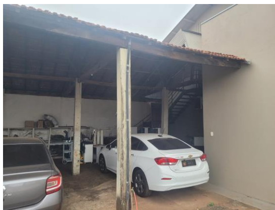
FOTO 12- GARAGEM A CONSTRUIR
