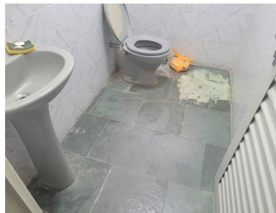
FOTO 06 – BANHEIRO A REFORMAR
