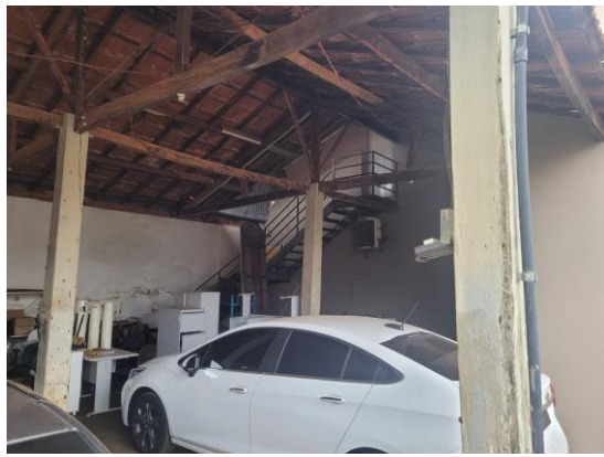
FOTO 14 – GARAGEM PARA CONSTRUIR
